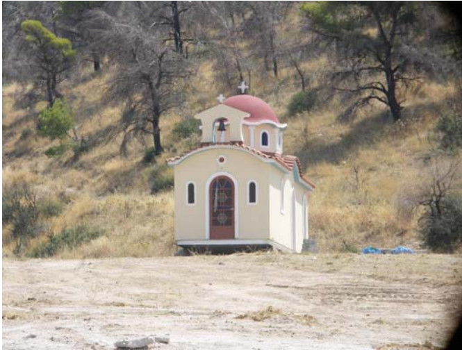
Φωτ. 1: Προκατασκευασμένος Ναός
